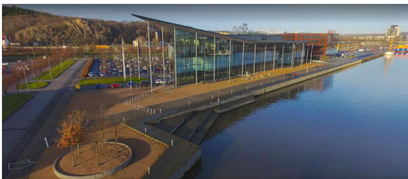
Kanalhuset från norr. Till vänster Pumpgatan
